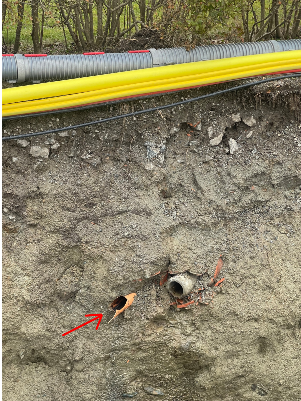
SI 0,00m Rør i grøft
