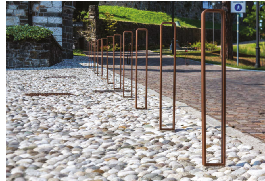
Eksempel på bruk av brostein i mindre format som overgang mot gangsoner i det historiske anlegget Borgo di Castello i Italia. Foto: Massimo Crivellari.
