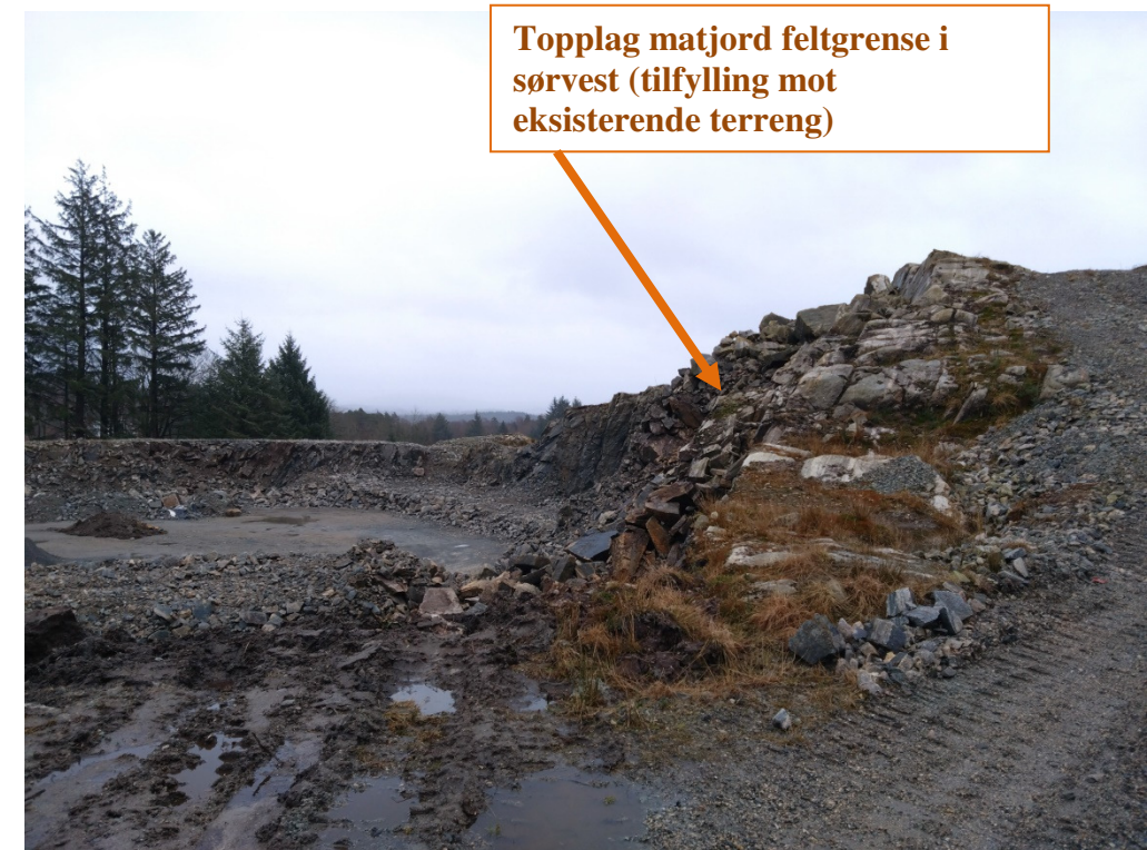
4. Oversikt, øvre fyllingshøyde matjord mot eksisterende terreng i sørvestlig del.
