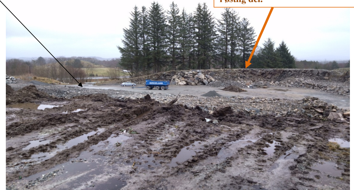
1. Oversikt – Fylling med matjord i sørvestlig del.
