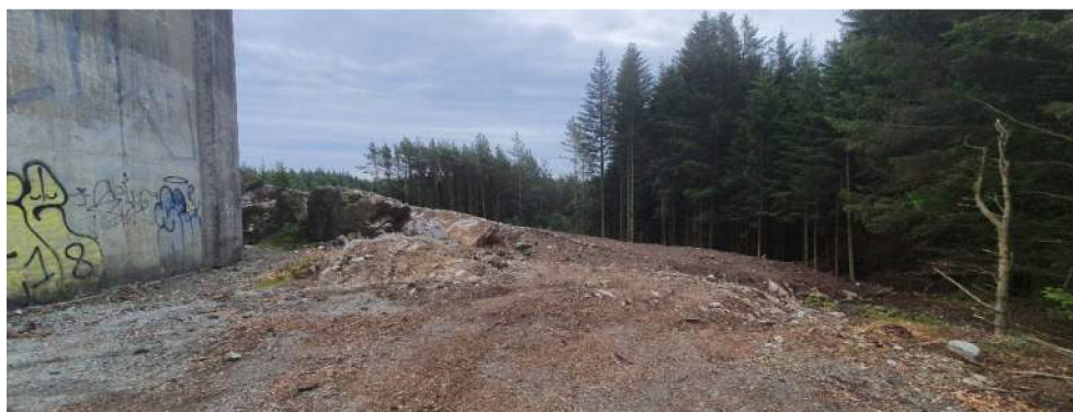
Figur 9: Bilde av plassen der det skal etableres adkomst til området der det skal bygges nytt høydebasseng. Bildet er tatt mot øst. Eksisterende høydebasseng sees til venstre i bildet. Oppstikkende berg nær høydebassenget må fjernes for å etablere adkomst.
