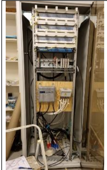
Figur 3: Eksempel fordelingsskap
