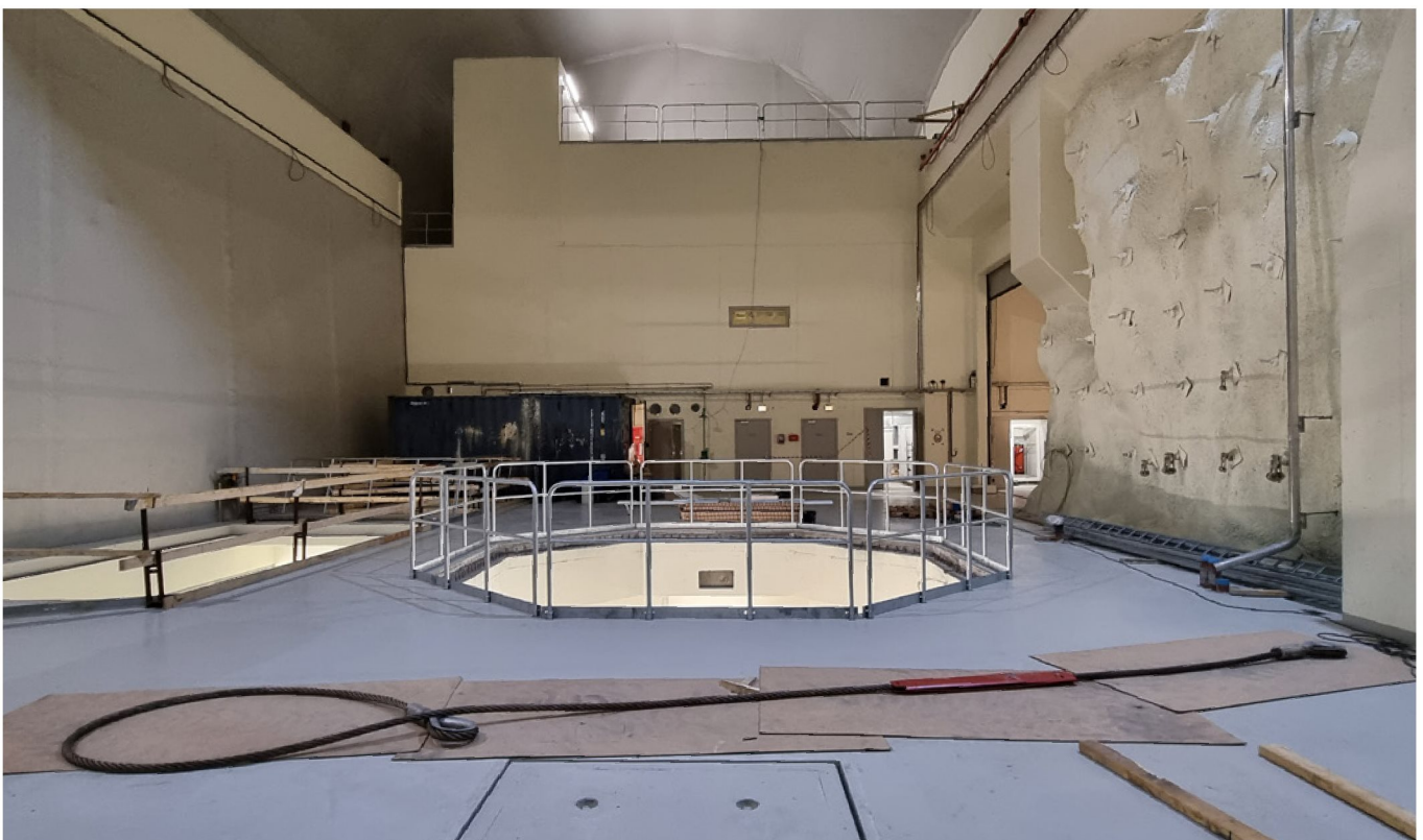
Løkjelsvatn kraftverk forventes å stå klart i løpet av 2023. Kraftverket ligger både i et verna vassdrag og et nasjonalt laksevassdrag. Moderne konsesjonsvilkår sikrer mer vann til laksen i vassdraget, så snart kraftverket settes i drift. Utbyggingen har god forankring og støtte fra miljø- og naturinteresser. Foto: SKL
