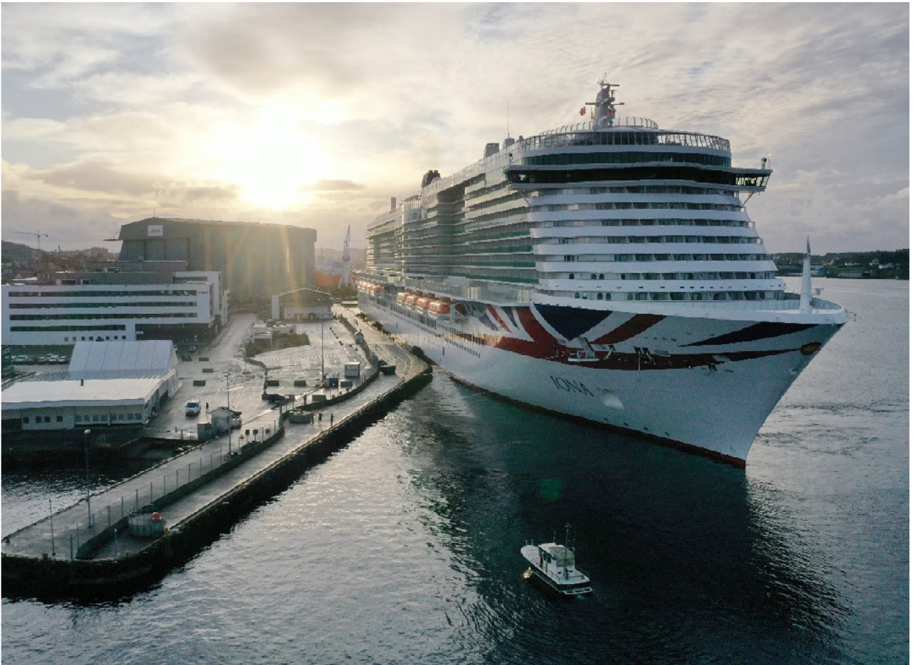
Havnekraft startet i fjor bygging av et høyspent landstrømanlegg for cruiseskip på Garpeskjær i Haugesund. Anlegget vil kunne levere en effekt på 12,8 MVA. Foto: Karmsund Havn IKS
