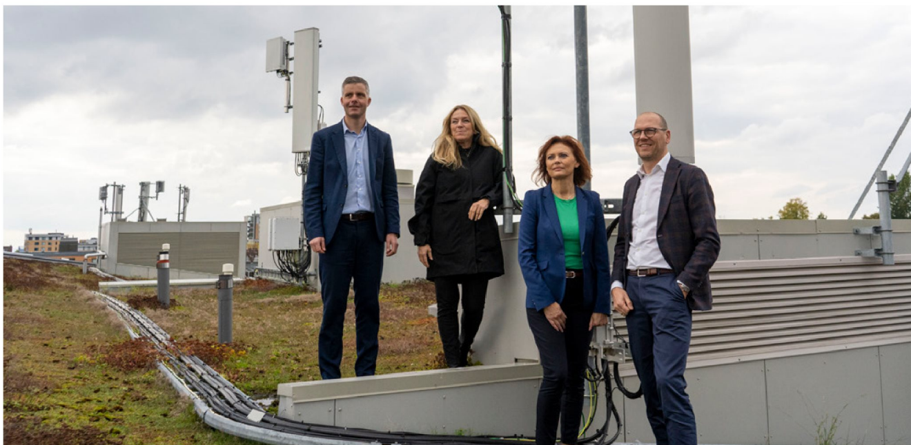
Sentrale bredbåndsselskaper fra hele Norge er med i et nyopprettet tårnselskap som skal bidra til å bygge Norges raskeste 5G-mobilnett. Her representert ved noen av de største selskapene foran en av Ice' eksisterende 5G-basestasjoner i Nydalen i Oslo. Fra venstre: Odd-Eirik Grøttheim, direktør NTE Telekom, Toril Nag, konserndirektør tele i Lyse samt styreleder i Ice og Altibox, Mariann Salvesen, direktør Haugaland Kraft Fiber og Ola Børke, direktør i Eidsiva Bredbånd. Foto: Sebastian Storvik
