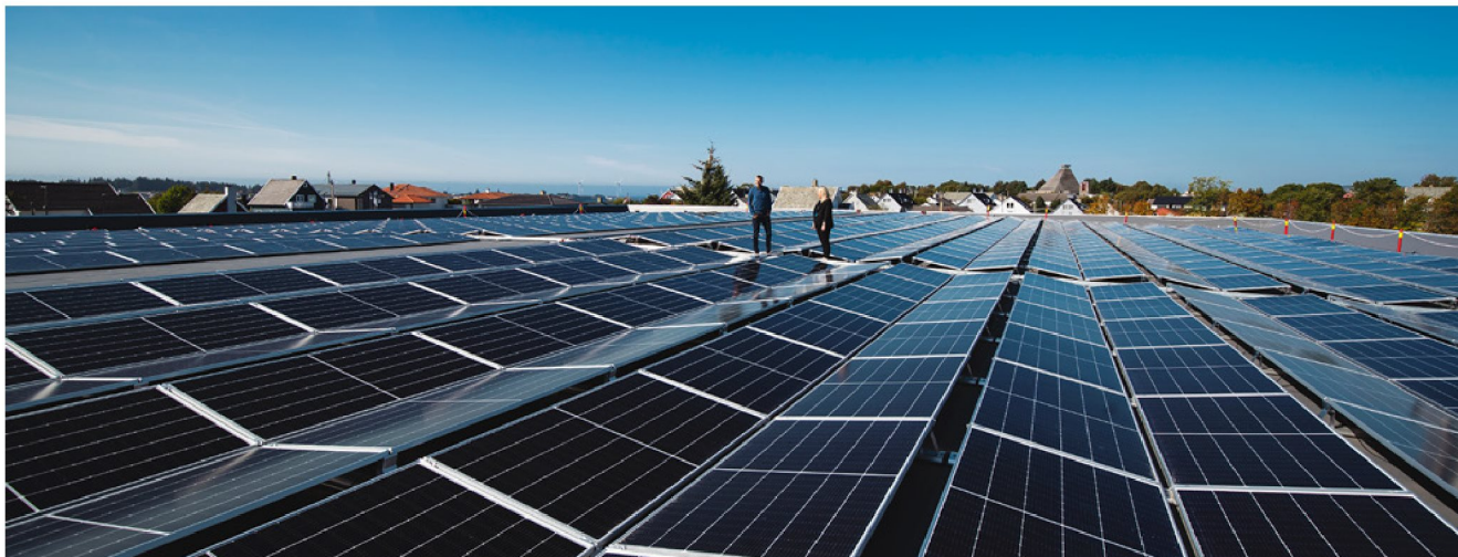
På taket av garasjelegget på Rossebø har Haugaland Kraft installert 938 solcellepaneler, som er et viktig bidrag til å redusere konsernets fotavtrykk. Foto: Haakon Nordvik
