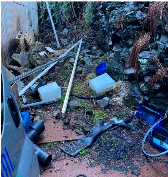
Bilde 1: Bilde fra baksiden av bygget i Avaldsnesvegen 72
