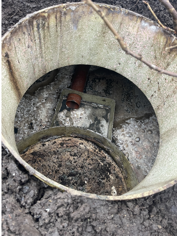
SI 0,00m Fra utløp septiktank
