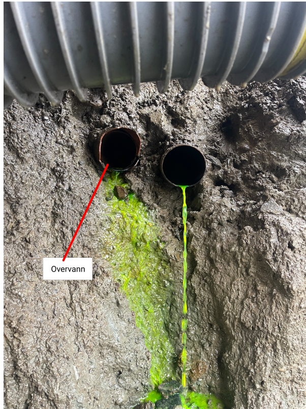
SI 0,00m Fra grøft mot hus
