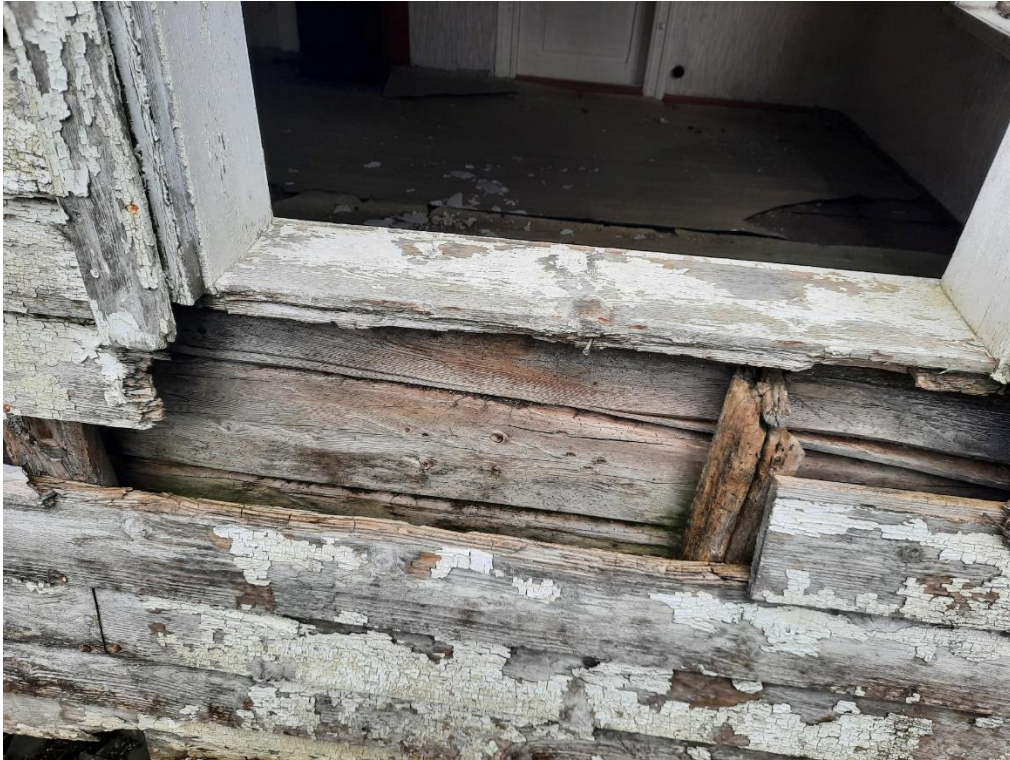
Yttervegger er tømmervegger som er påført med stolper og kledning på yttersiden.
