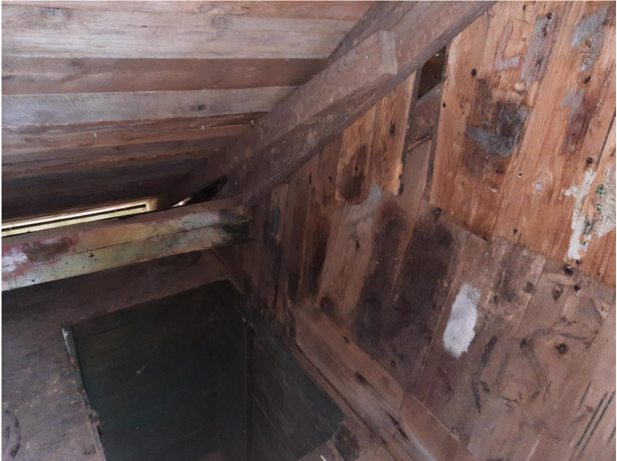
Konstruksjon ved trappe åpning, sperrfot på topp tømmervegg
