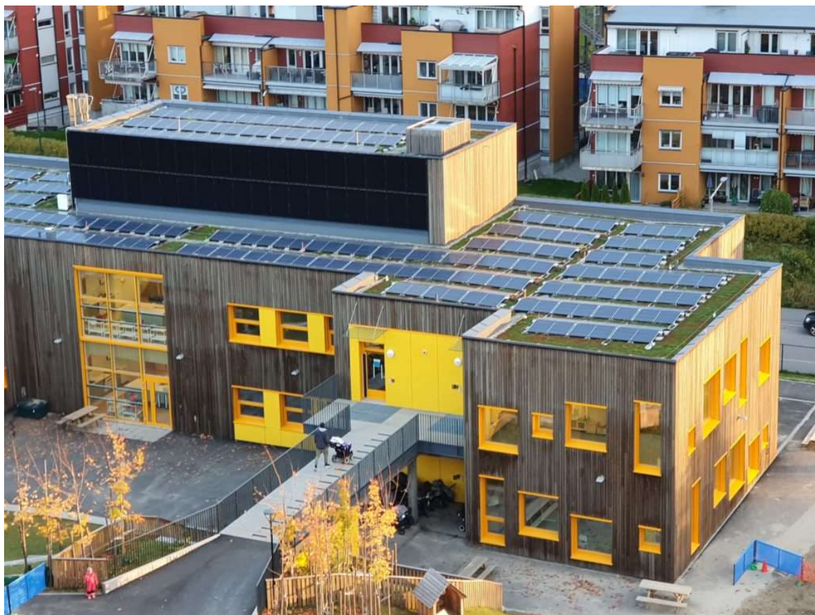
Figur 1 Vollebekk barnehage med solceller og sedumtak. Foto: http://www.blomstertak.no/sedum-og-solceller-pa-vollebekk-barnehage/
