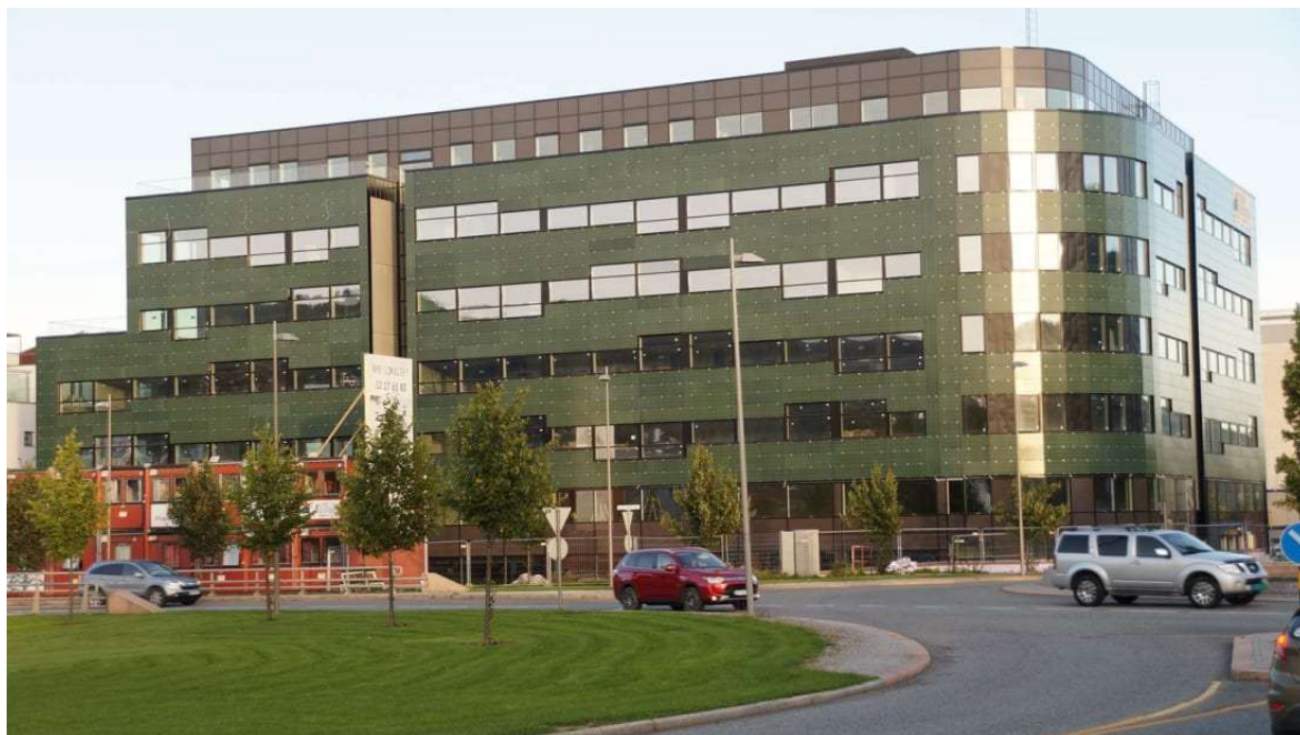
Figur 2 Solsmaragden i Drammen har solceller i fasaden med grønn farge. Foto: Union Eiendomsutvikling.
