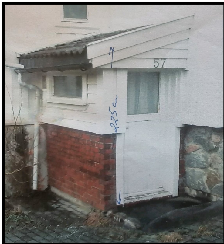
Figur 3 – Punkt 1 - Overbygget kjellertrapp
