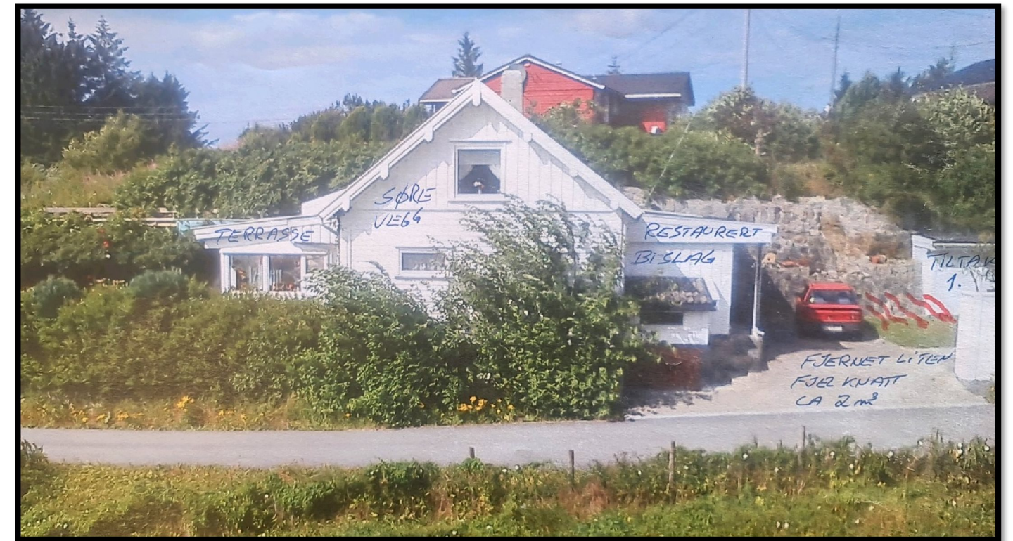
Figur 2 – Fasade mot sør, Etter kontroll fant vi at nevnte fjellknutt utgjorde ca. 1 m 3
