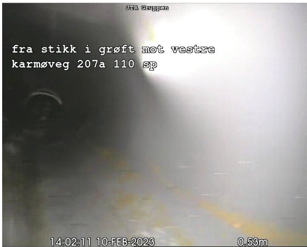
DF 0,50m Deformasjon, Gradering 1, Type: Punkt, KI3
