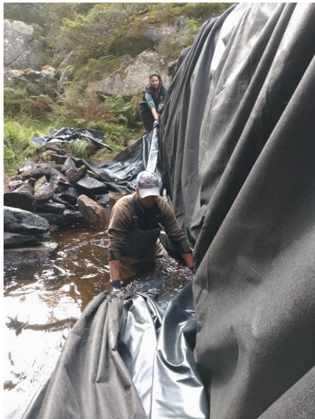
Representant i styringsgruppa i Sjøørretprosjektet i Karmøy, Gunnleiv Ferkingstad og naturforvalter i Karmøy kommune, Gunvor Skjelstad, jobber møysommelig for å legge duk inntil demning for å heve vannspeilet. Her fra Stolsåna.
