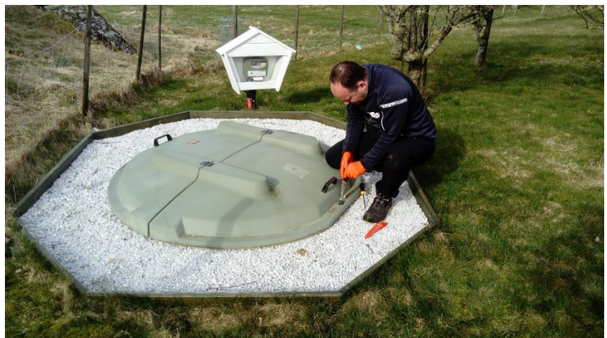
Nyvalgt leder i tilsynsgruppe spredt avløp, Wilhelm Fjetland Trodahl, kjenner alle triksene i boka, og dirker opp et lokk til et minirensanlegg.
