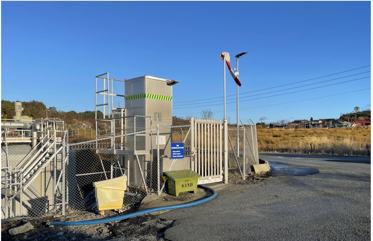
Figur 15 Bilde av Vestbøvegen der kjemikalier blir levert. Vegen ligger på ca. kote 16. Kilde: LY areal & landskap
