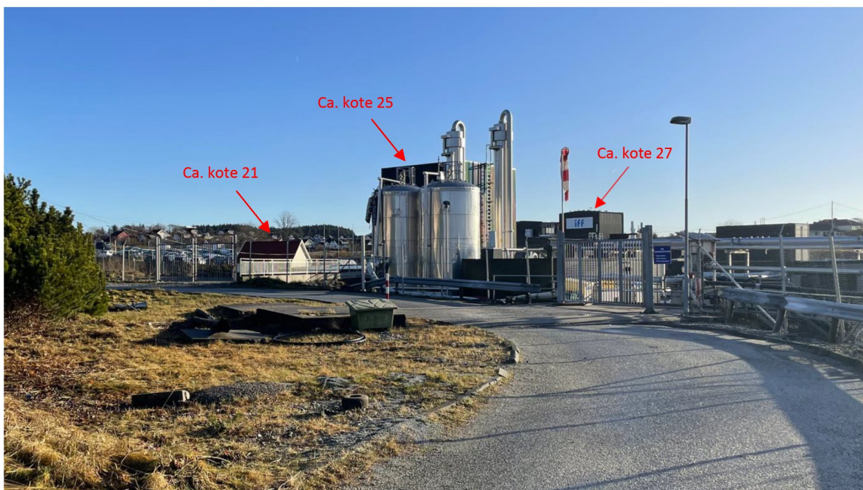
Figur 14 Bilde av avkjørsel ved Vormedalsvegen der kjemikalier blir levert. Vegen ligger på ca. kote 16. Bygningsmassen som ses i bakkant av tanker er ca. kote 25. Kilde: LY areal & landskap
