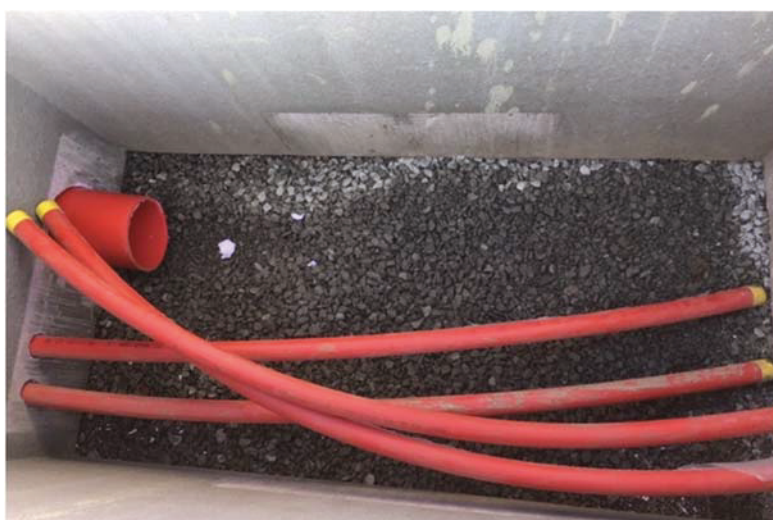
Figur 14. Innføring av rør i firkant kum
