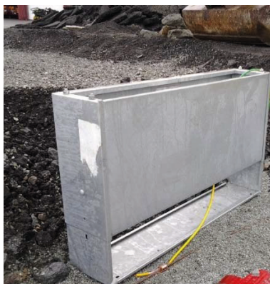
Figur 30. Innføring av isolert jordledning i kabelskap
