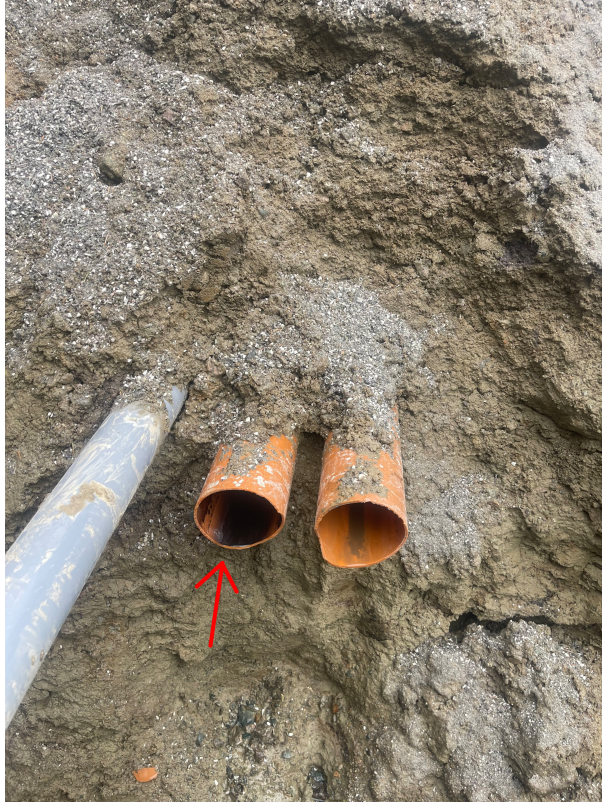
SI 0,00m Stikk i grøft
