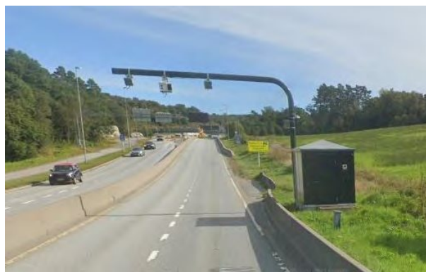
Figur 1.6: Rørportal (halvportal) i Bypakke Bergen. Foto: Google street view.
