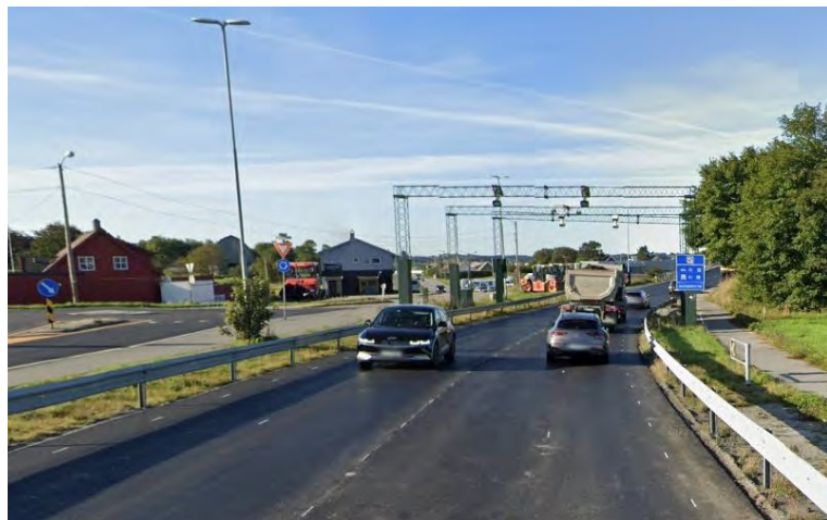
Figur 2.23: Dagens bomstasjon på E134 ved Norheim, sett fra nord. Google Street view.
