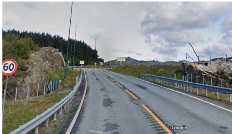
Figur 2.29: Fv. 554 T-forbindelsen, sett fra sør. Bomstasjonen planlegges plassert i 60-sonen i bildet. Google Street view.
