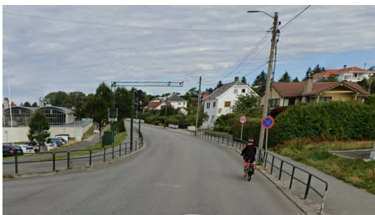
Figur 2.11: Dagens bomstasjon i Salhusvegen, sett fra sør. Google Street view.
