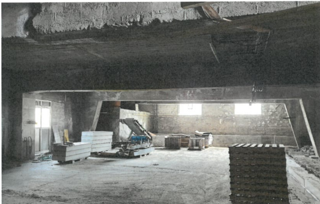
Innvendig. De kraftige støpte dragerne som bærer det flate taket i betong, begrenser dagens truck-kjøring i dette lagerrommet.
