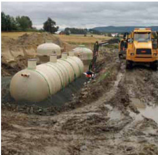
Slamavskiller med infiltrasjon under bygging.
