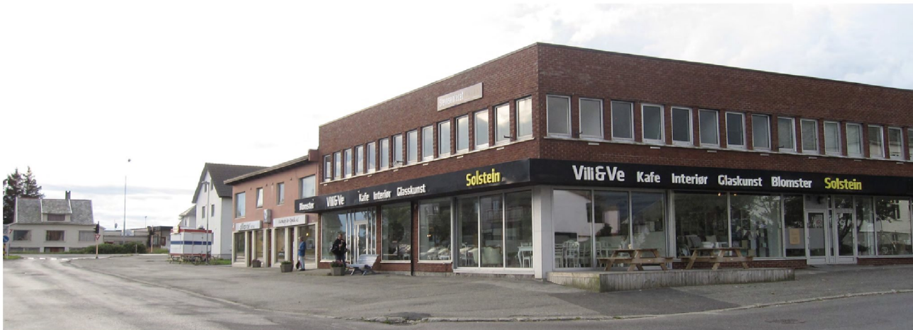
Over: Mot nord
