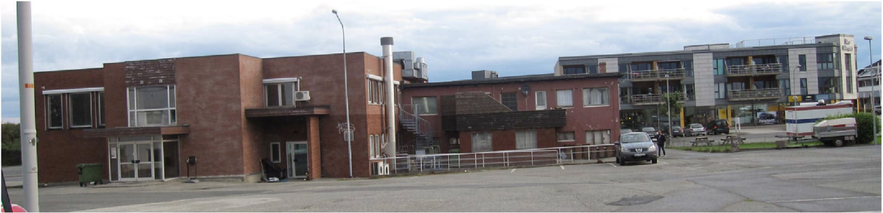
Over: Mot sør sett fra parkeringsplass.
