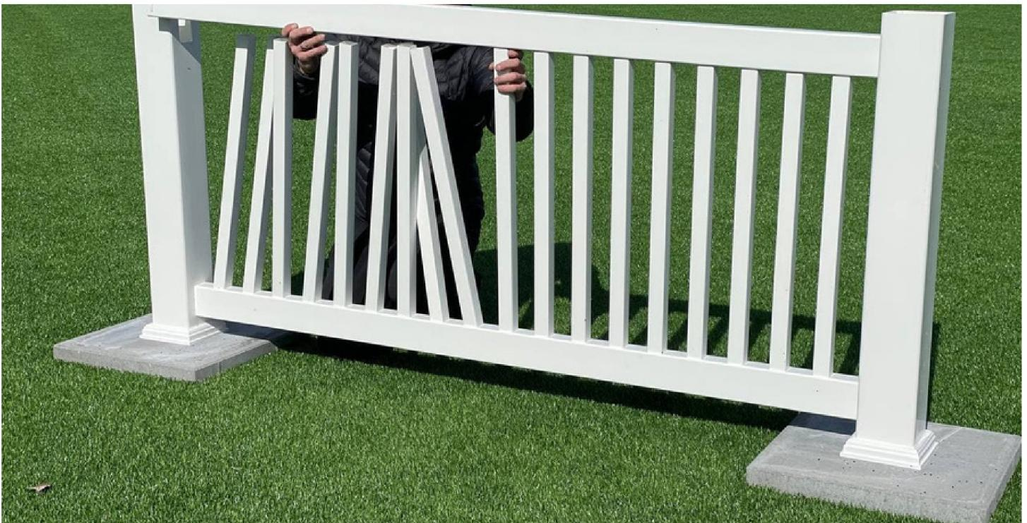
Når spilene er på plass, skal toppvangen klikkes på plass i stolpen. Bilde av mothakene ser du under.
