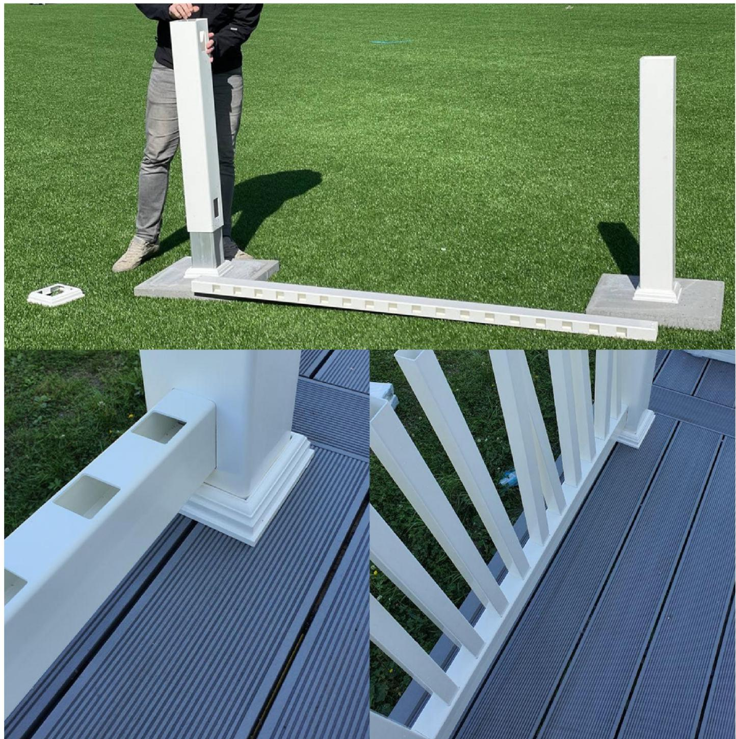
Når alle spilene er plassert i bunnvangen, kan tre av spilene fra en side føres opp i toppvangen. Deretter klikkes mothakene på toppvangen inn i stolpen, før de resterende spilene føres opp i toppvangen.
