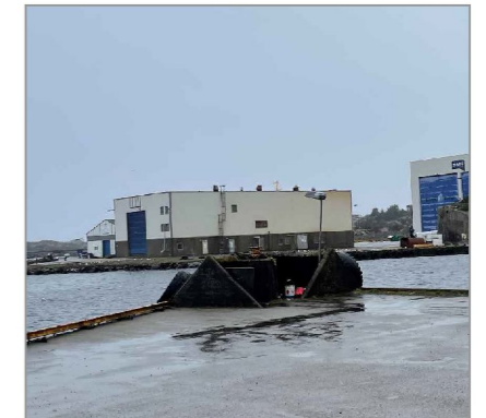
Dagens situasjon sørvest, betong konstruksjon
