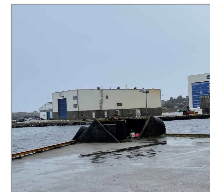
Dagens situasjon sørvest, betong konstruksjon
