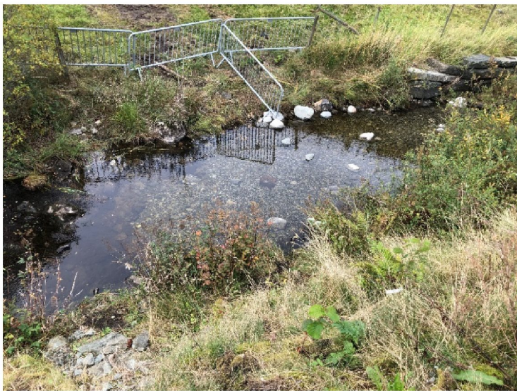
Slik så det ut etter gytegrusutlegg i 2020. Merk at det var for lite store steiner i forkant av utlegget. Det førte til utskylling.
