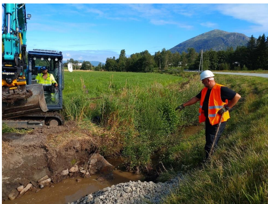
Tore Skogen i Vindafjord Jakt- og Fiskelag viser hvor gytegrus og stein skal plasseres i Åmstølbekken.
