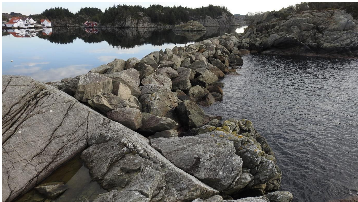
Viser ytterskråning fra landfestet mot Øyaholmen
