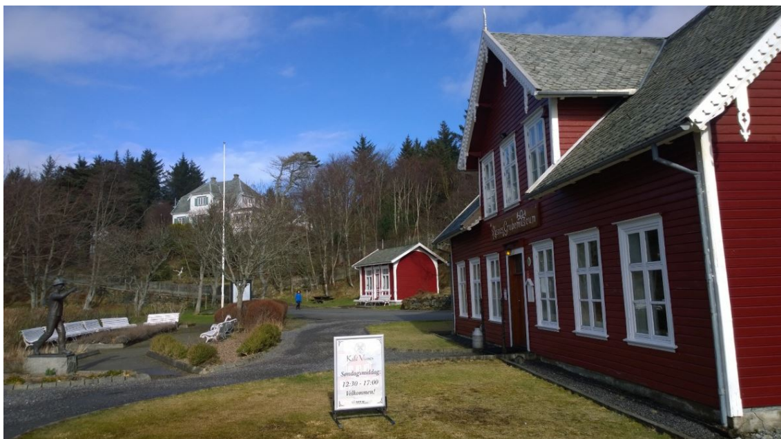
Det gamle administrasjonsbygget fra 1869. Rogaland fylkeskommune, 17.03.2017 14:24
