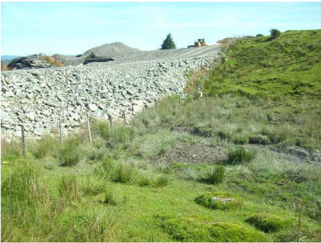
13. Bekkeløp over beite. Utløp ved traktorveg til naboeiendom (gnr./bnr. 118/1).
