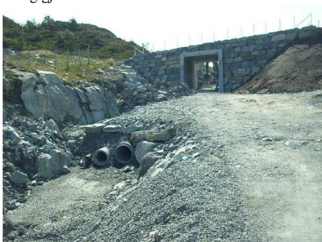
9. Felt 1: undergangen i sør. Utløpsrør for drens vann fra T-forbindelsen (Kjerkevegen til h.)
