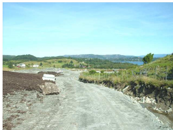
10. Felt 1: Østgrensen. Åpen grøft for drens- og flomvann, beliggende langsetter Kjerkevegen.
