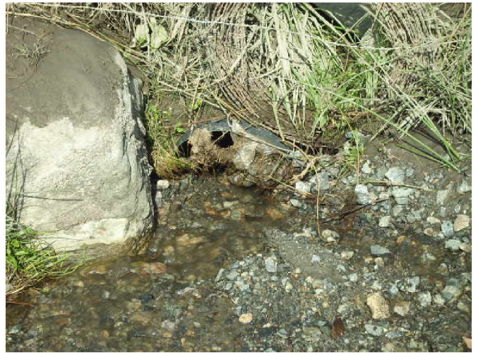
14. Innløpet fra bekk over gnr/bnr. 118/2 (søker) til rør under traktorveg beliggende på gnr./bnr. 118/1.
