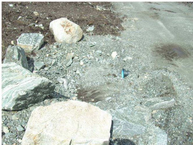
13. Innløp rør under Kjerkevegen, detalj. Se ellers bildetekst foto nr. 12.
