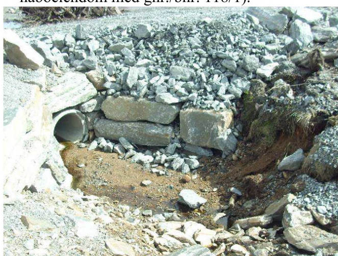
11. Innløp under Kjerkevegen fra åpen grøft (på bnr. 1). Se ellers tekst foto nr. 10.
