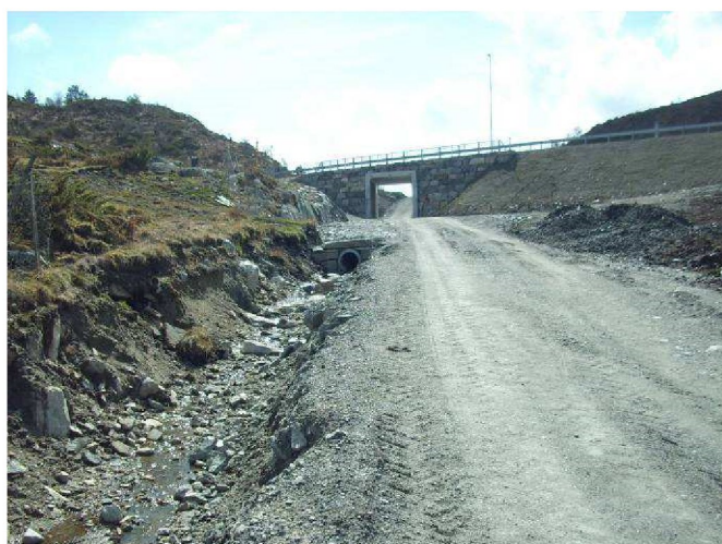
3. Lukket bekkeløp etableres her og sammenkobles med dette etablerte avløpet fra T-forbindelsen.
