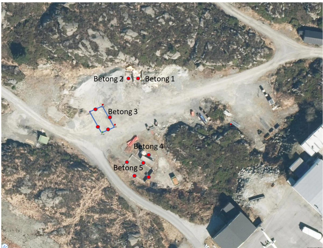
Figur 7: Flyfoto av det tidligere brannøvingsfeltet (BØFB) med markering av betongkonstruksjoner som må fjernes før etablering av grøfter, brønner og utgraving. Betong 1, 2 og 4 er plater på mark, mens betong 3 og 5 er ringmur. Betong 3 er ringmuren for det tidligere brannøvingsbassenget.
