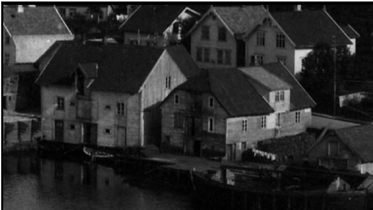
Figur 20: Historisk bilde av eiendom 58/10. Byggene i bildet er erstattet.
