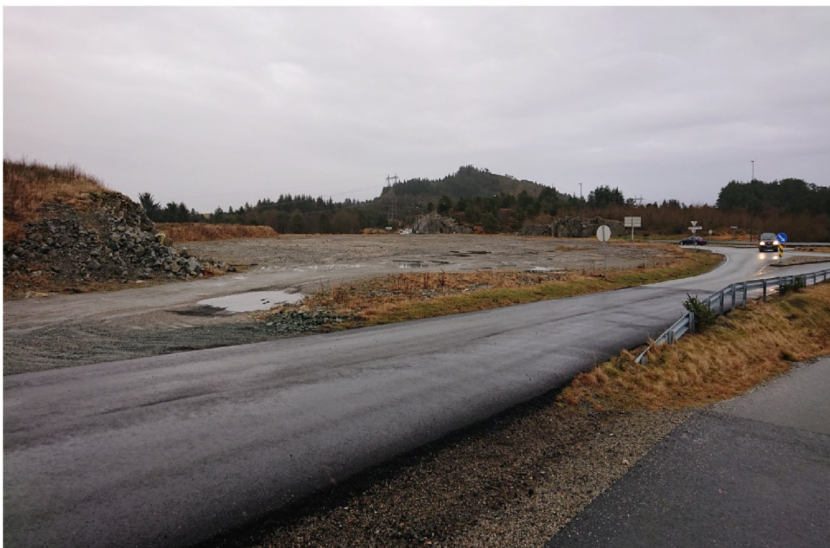
2. Oversikt, vestlig del – mot rundkjøringen.
