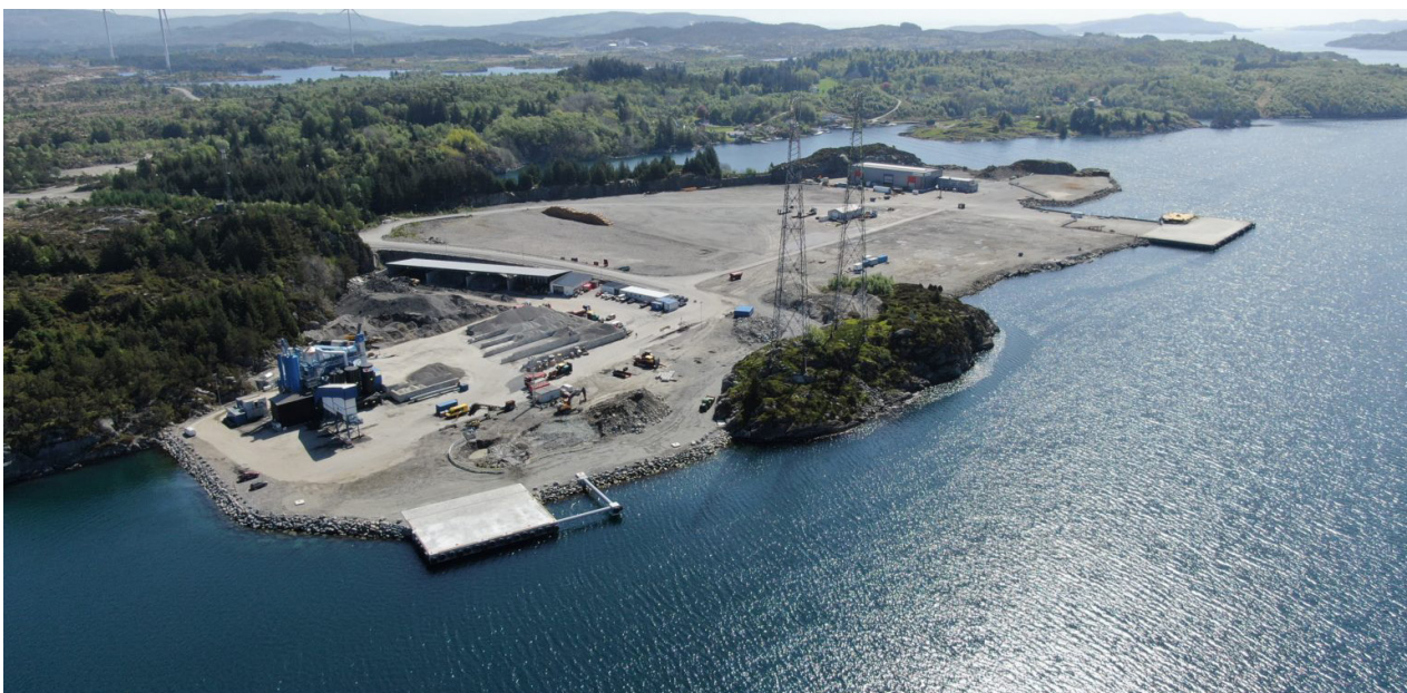
Gismarvik Havn med kaianlegg i nord og sør
