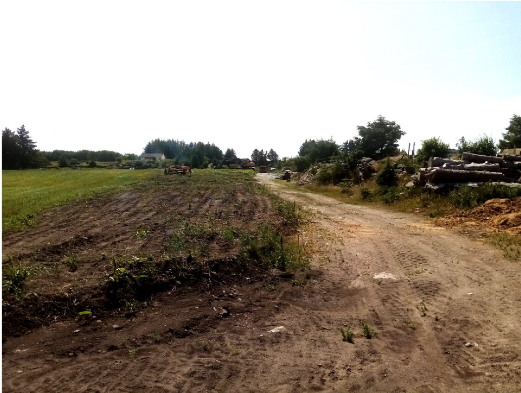
1. Etablert oppgradert fast landbruksveg i feltets vestgrense.
