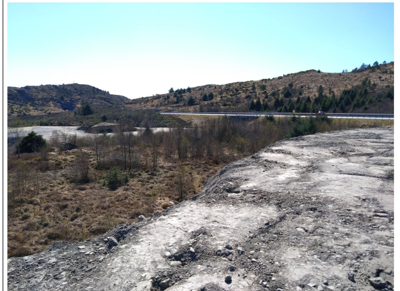
4. Utført arbeid i feltets sørvestlige del (til høyre i bildet).
