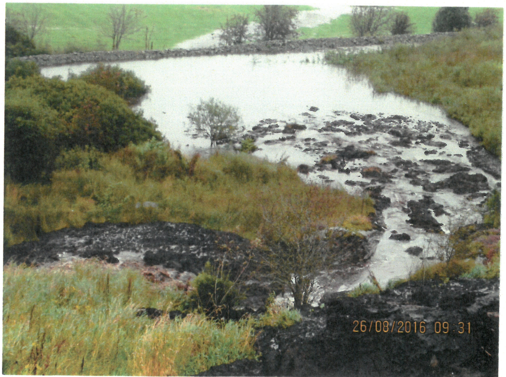
Foto 2 Oversikt flomvann: Omsøkte Felt 1, utløp eksisterende bekkeløp – som får vann via koblingspunkt fra T-forbindelsen (se vedlegg 7: foto 1 og 2) og usikret grøft (se vedlegg 7: foto 3).
