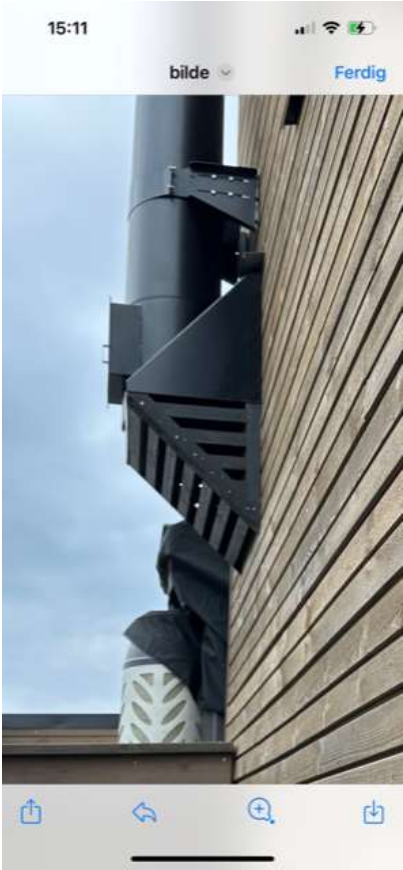
Kvass kant ved pipe utbedret.
