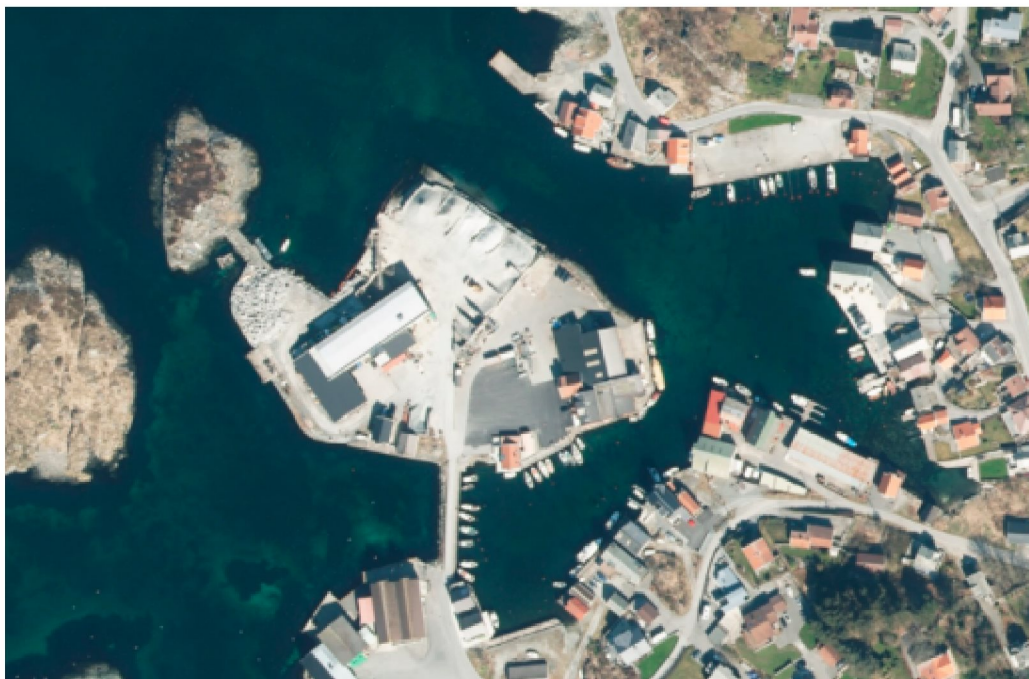
Figur 1. Næringsområde på Sveholmen. Bygningen hvor man nå skal tilrettelegge for overnatting i tredje etasje ligger til venstre på bilde.
