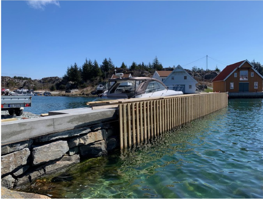
foto av moloen som er bygget, kilde: Syre båtforening
