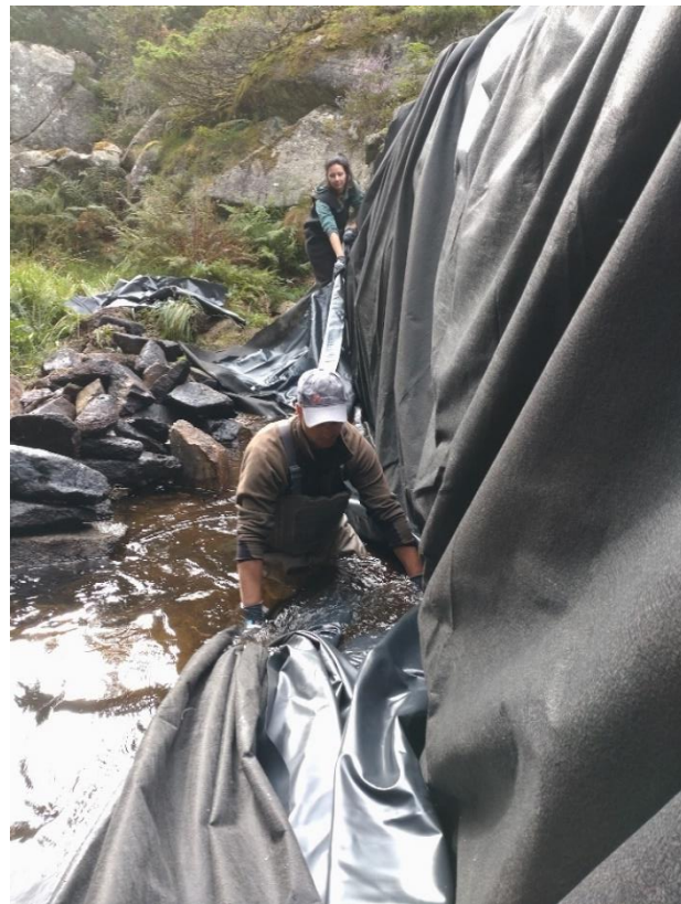
Representant i styringsgruppa i Sjørretprosjektet i Karmøy, Gunnleiv Ferkingstad og naturforvalter i Karmøy kommune, Gunvor Skjelstad, jobber møysommelig for å legge duken inntil demningen for å heve vannspeilet. Her fra Stolsåna.
