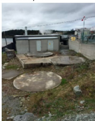
Bilde 4: fundamenter etter tre tidligere tanker, som kan ses i bilde 2.
