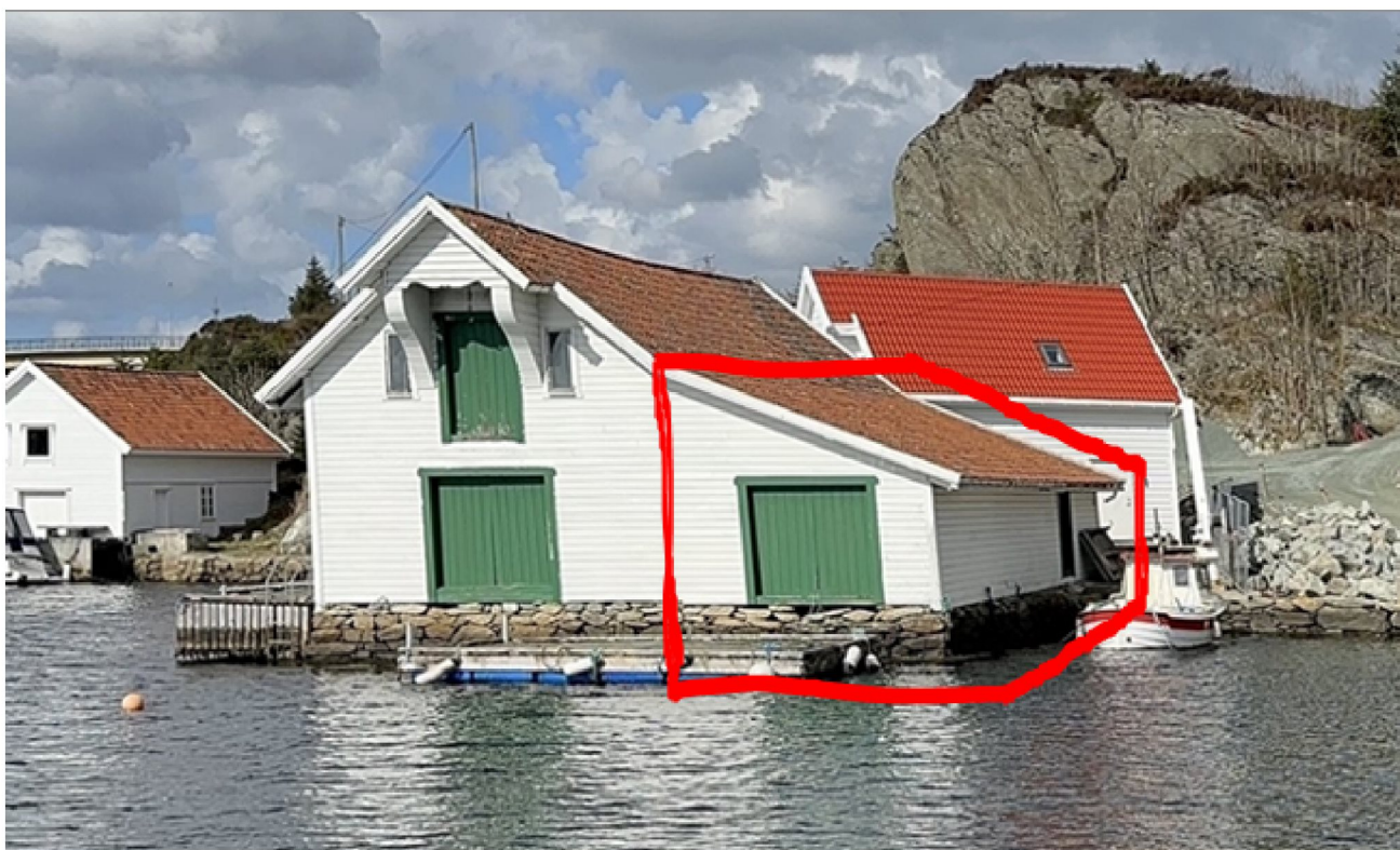
Figur 3: Tilbygget som kalles «skut», markert med rødt, kan rives og erstattes av et nytt tilbygg. Det kan også føres opp et takopplett i bakkant av byggets hovedtak som kan kobles sammen med et eventuelt nytt tilbygg der dagens skut ligger.
