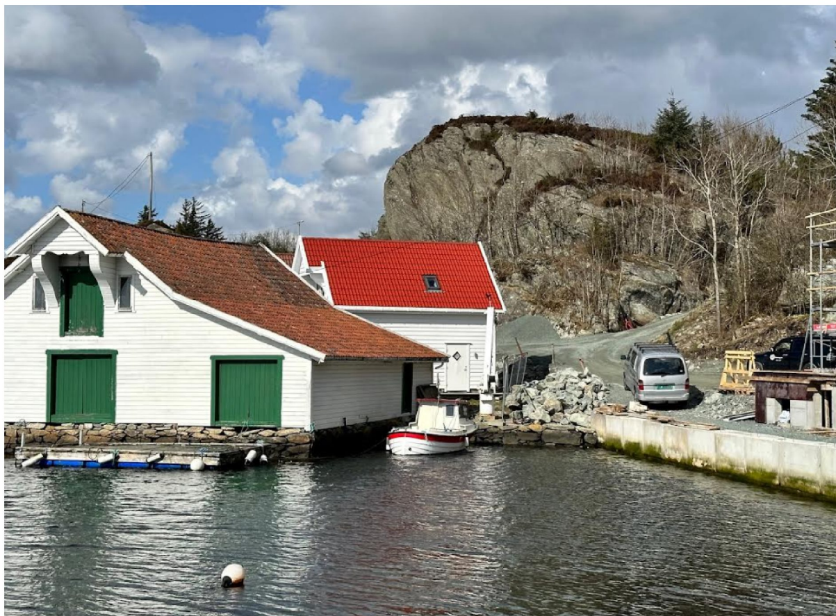
Figur 08: Området er i hovedsak utbygd. Bygg i midten har i dag midlertidig brukstillatelse til fritidsbolig og inngår i planområdet.
