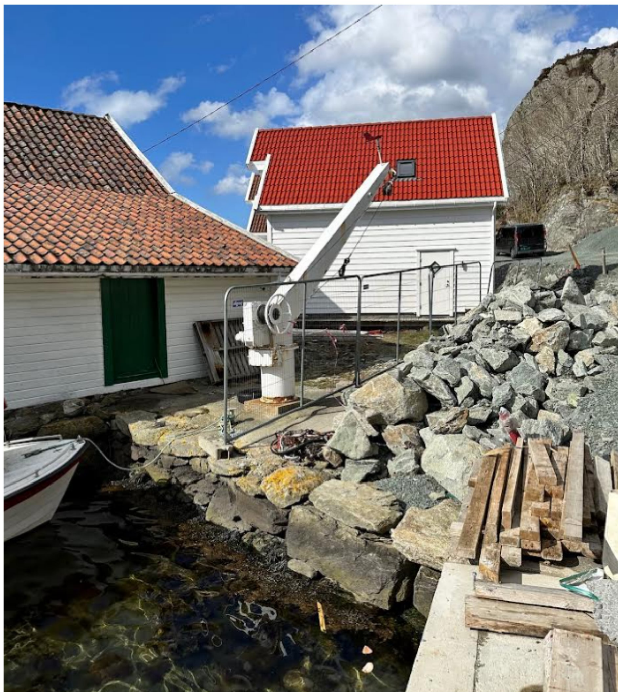
Figur 09: Området består av utfylling i form av kai som er bygget opp med stein.
