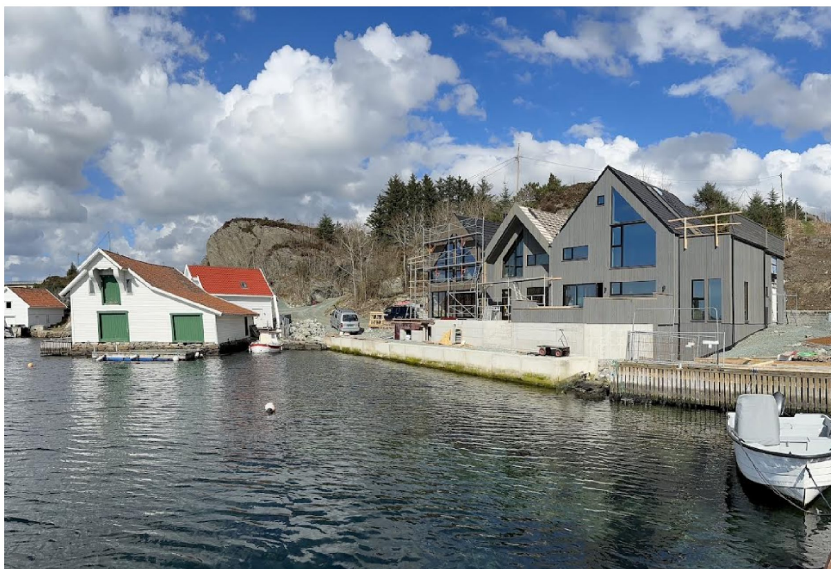
Figur 07: Byggene til venstre inngår i planområdet, mens bygg (grå) til høyre er under oppføring og er tilgrenset planområdet.
