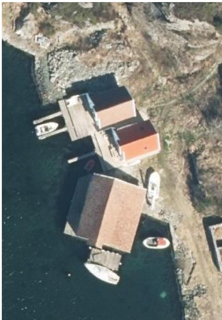
Figur 10: Området sett ovenfor. I dag er det anlagt gangveg langs vestsiden av byggene. Disse tre byggene i tillegg til planert området nord inngår i planområdet.
