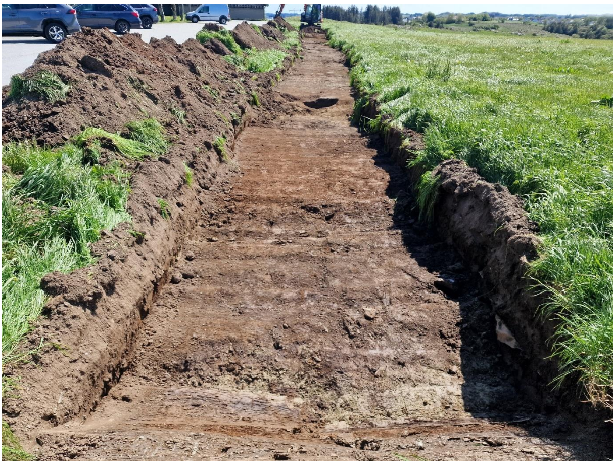
Figur 16: Sjakt 4.1. Bilde tatt mot S. Foto nr. 42.
