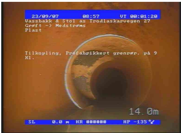
07.09.2023 08_48_21_1625b56c-a9c3-4d50-9638-de68b83aa4a7_20230 907_085042_614.jpg, 00:01:16, 14.00 Tilkøpling, Prefabrikkert grennrør, på 9 Kl. / Påkobling nr 25
