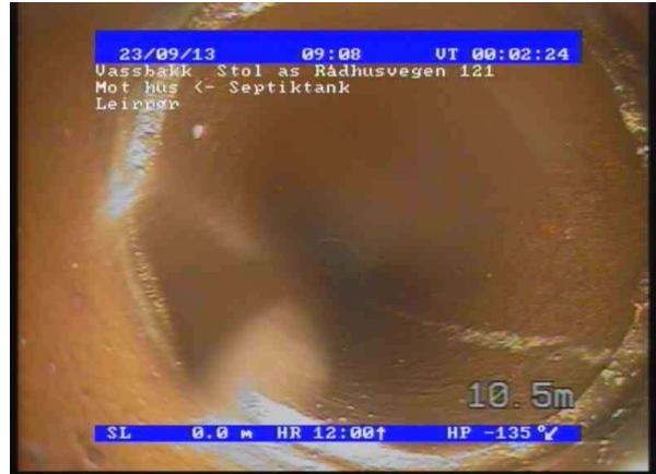
13.09.2023 08_56_59_6e2b5316-5725-4f7f-b7ce-000bd05d1906_20230914_081043_204.jpg, 00:02:25, 10.50 Forsk. skjøt forsk. er mellom hele og 2 ganger rørtyk. eller skjøten er delvis åpen, av 8 Kl. til 4 Kl., Tverrforskjøvet
