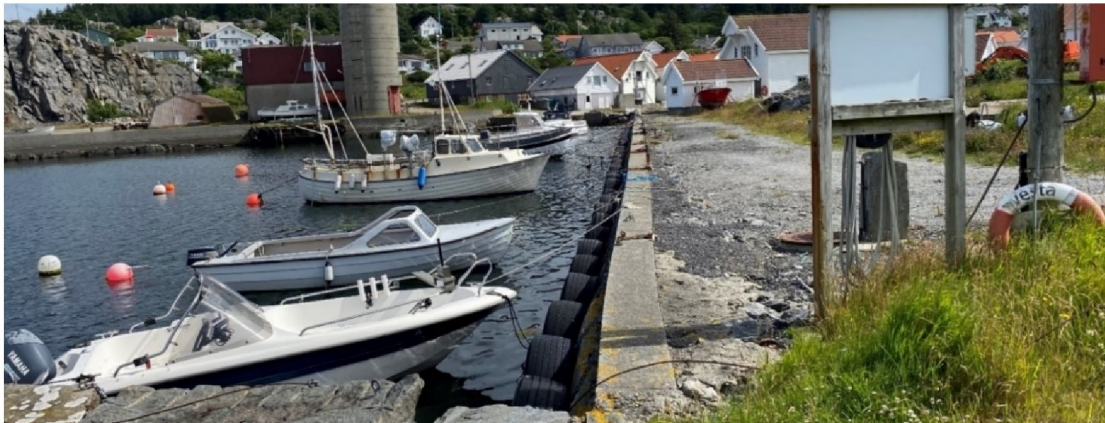
Figur 15 – Støpt betongkant i brygge vest i planområdet.
