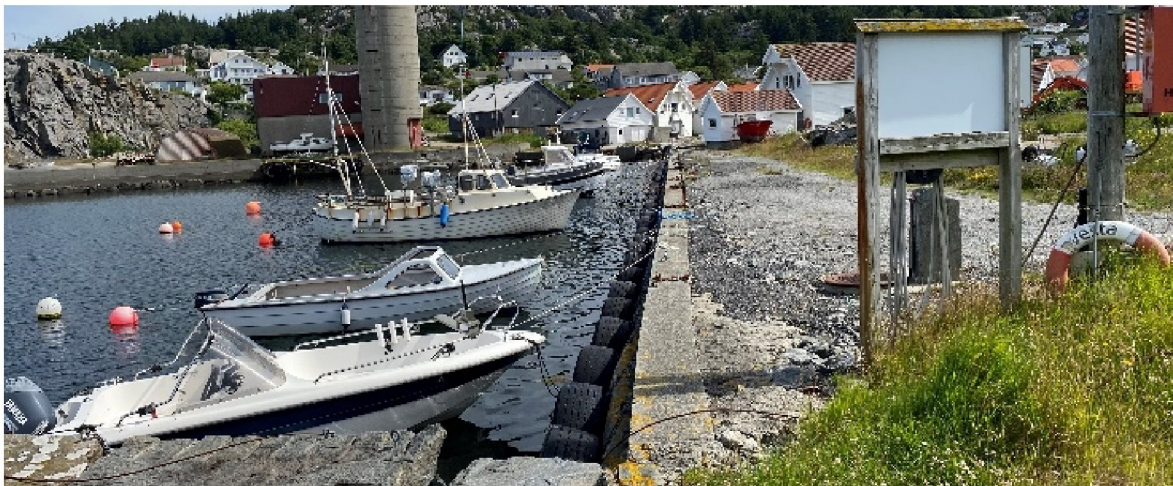
Figur 02 – kai området, ca. 15 cm bryggekant er støpt direkte på massive stein blokker.
