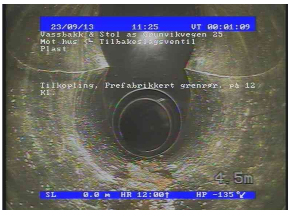
13.09.2023 10_47_59_3b0a0d32-3bf3-4ba4-9228-297591feeda7_202309 13_111910_220.jpg, 00:01:06, 4.50 Tilkopling, Prefabrikkert grennrør, på 12 Kl.
